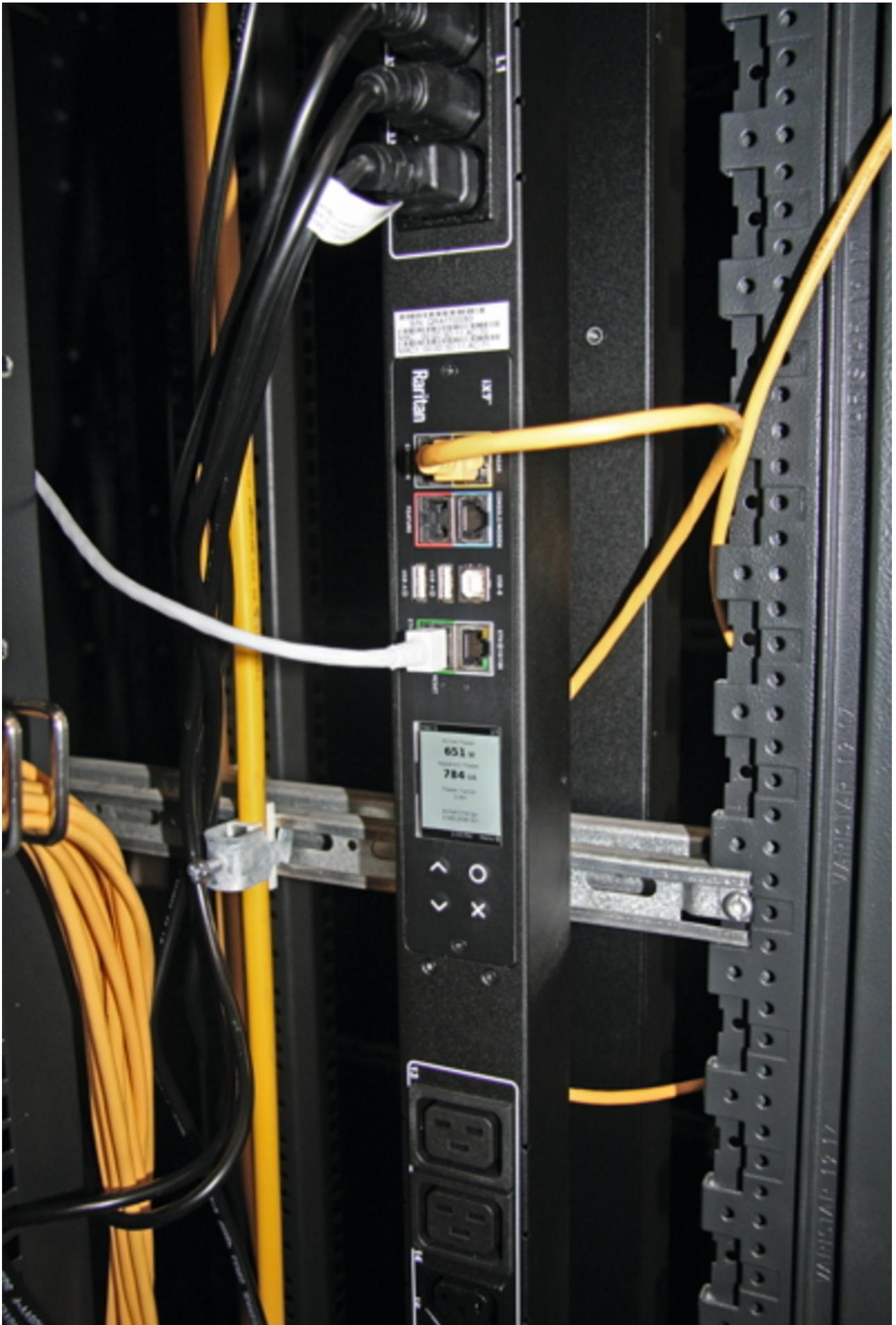
Alle Geräte inklusive Sensoren sind direkt an den beiden Raritan PX5000 Intelligent Rack PDUs im Schrank angeschlossen. Bild: Wobcom
