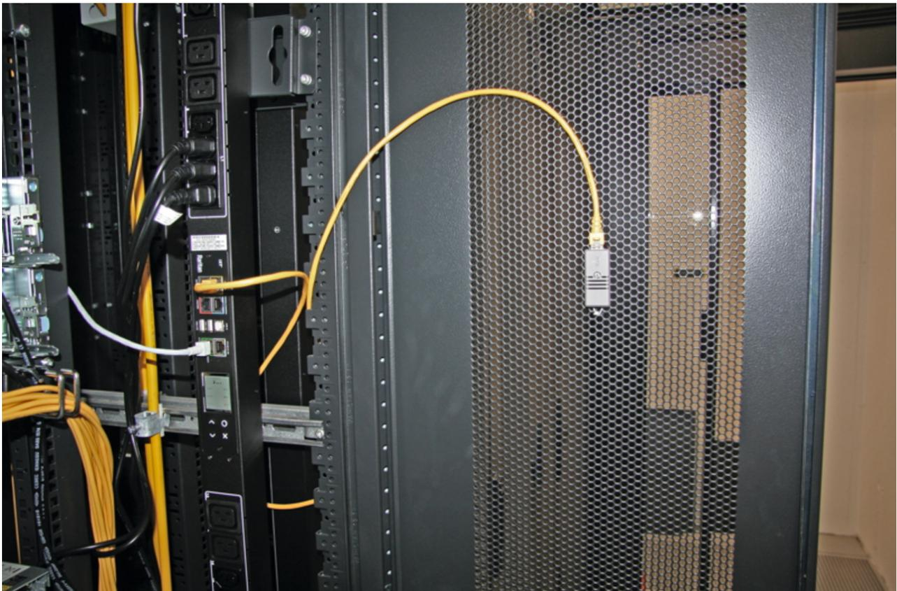
Wobcom arbeitet mit Warm- und Kaltgang-Einhausungen und misst jeweils vorn und hinten im Schrank mit kombinierten Temperatur- und Luftfeuchtesensoren. Sie sind direkt an der Schranktür befestigt. Bild: Wobcom
